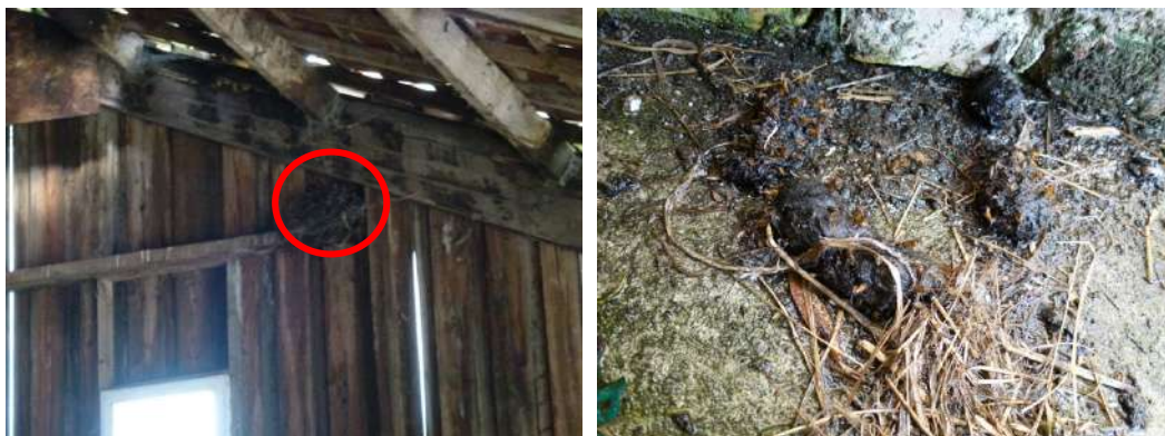
Links het nest in de hooischuur (rood omcirkeld) en rechts de braakballen van kerkuil onder het nest. Op de linker foto zijn tevens sporen van vogels (hoogstwaarschijnlijk kerkuil) op de balk naast het nest te zien.
