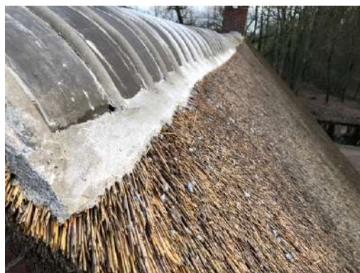
Links een bovenaanzicht van het rieten dak van de hoeve met nokpannen. Rechts de nokpannen welke netjes zijn afgesmeerd.
