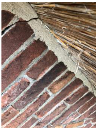
Links en midden een detailfoto van de kopgevel (respectievelijk de voor- en achtergevel) waarop te zien is dat het riet goed aansluit op de gevel of is afgewerkt met cement. Rechts een detailfoto van de aansluiting van het dak op de langgevel (linker gevel). Ook hier zijn geen spleten of kieren waar vleermuizen onder kunnen kruipen.
