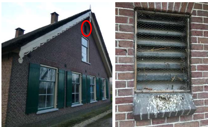
Links de voorkant van het woonhuis met in de nok het rooster (rood omcirkeld) en rechts het rooster zelf met gaas ervoor.
