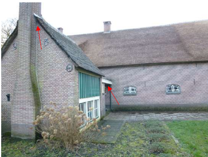
De uitbouw en een deel van de hoeve (rechtsachter). Met pijlen is aangegeven waar de detailfoto's van zijn.
