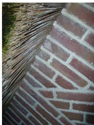
Links en midden een detailfoto van de kopgevel (respectievelijk de voor- en achtergevel) waarop te zien is dat het riet goed aansluit op de gevel of is afgewerkt met cement. Rechts een detailfoto van de aansluiting van het dak op de langgevel (linker gevel). Ook hier zijn geen spleten of kieren waar vleermuizen onder kunnen kruipen.
