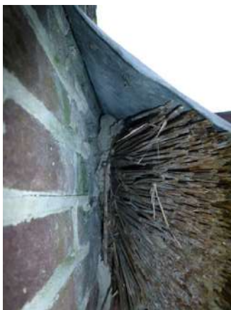
Links de aansluiting van het rieten dak op de gevel en schoorsteen. De ruimtes bij de loodslabben zijn opgevuld met cement zodat er geen vleermuizen in kunnen. Rechts de overgang van het platte dak naar de gevel van de hoeve waar spleten (in het verleden) zijn opgevuld met porschuim.
