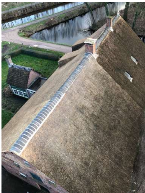
Links een bovenaanzicht van het rieten dak van de hoeve met nokpannen. Rechts de nokpannen welke netjes zijn afgesmeerd.
