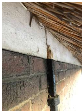
Links en midden een detailfoto van de kopgevel (respectievelijk de voor- en achtergevel) waarop te zien is dat het riet goed aansluit op de gevel of is afgewerkt met cement. Rechts een detailfoto van de aansluiting van het dak op de langgevel (linker gevel). Ook hier zijn geen spleten of kieren waar vleermuizen onder kunnen kruipen.
