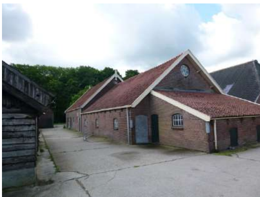
Locatie E, het meervoudige gebouw
