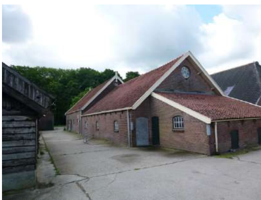
Locatie E, het meervoudige gebouw
