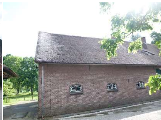
Locatie G, een deel van het woonhuis
