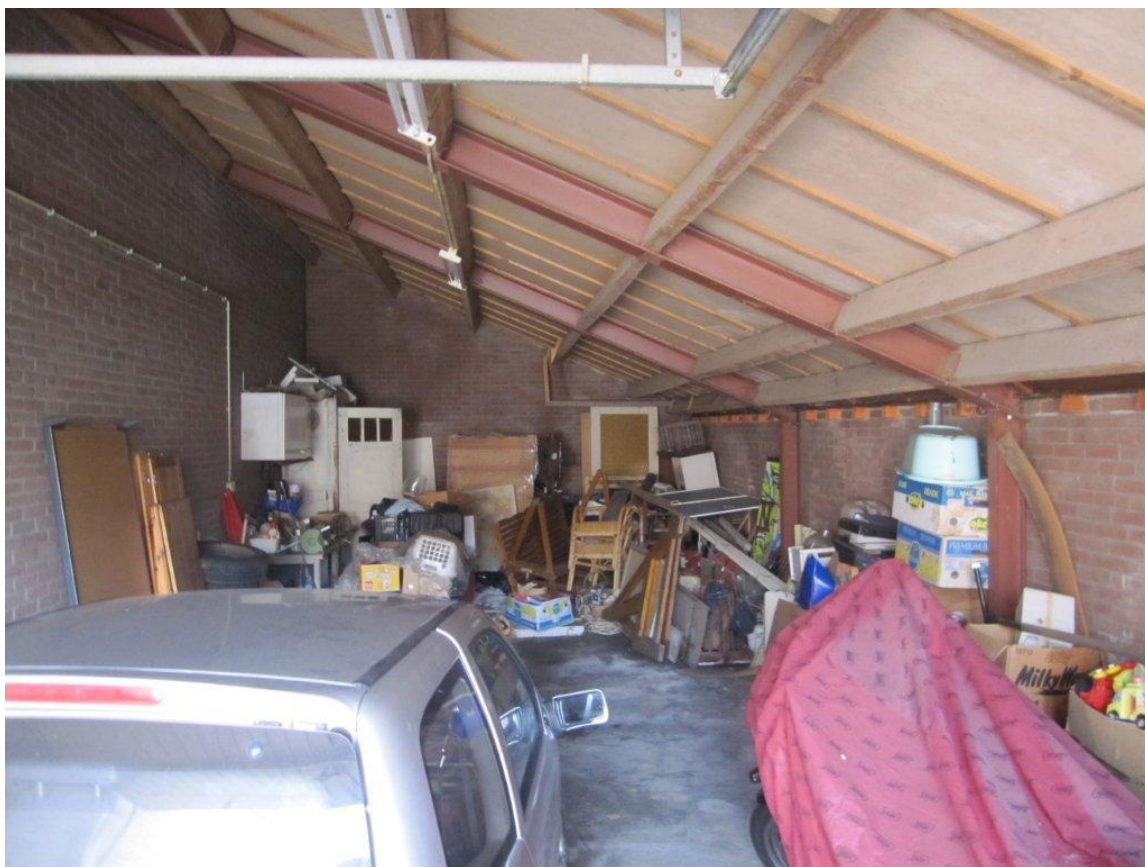
Interieur aanbouw loods
