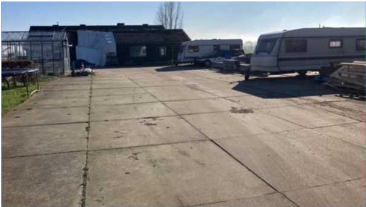
Foto van de aangebrachte verharding bij Willeskop 85b, 7 februari 2023
