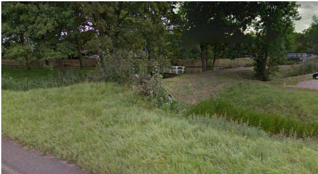
Afbeelding 3.7. Dijk ter hoogte van het parkeerterrein, gezien vanaf de N204 [ref. 5.]
