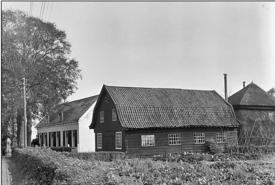
Figuur 2.22 Het erf aan de Liefhovendijk 2 met de boerderij, de timmermanswerkplaats en de hooimijt bij de aanwijzing als rijksmonument in 1966 (Van der Wal 1966, via Rijksmonumenten.nl 2018).
