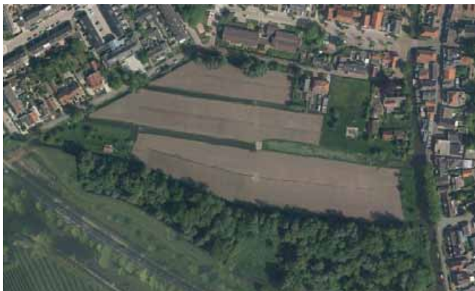
Figuur 1 Luchtfoto Bosje van Cromwijk, huidige situatie
