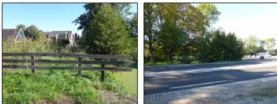
Figuur 2.17 Links; het onbestrate zuidelijke deel van de Liefhovendijk is afgesloten met een hek. Rechts; het oude dijktracé is ten zuiden van de M.A. Reinaldaweg niet meer als zodanig herkenbaar door demping van de sloten en de aanwezige begroeiing (foto; E.A.M. de Boer, 27 september 2018).
