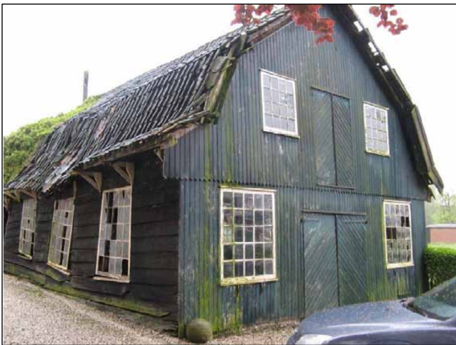
Figuur 2.23 De inmiddels gesloopte timmermanswerkplaats ten westen van boerderij Liefhoven (Monumentencommissie Montfoort 2016).
