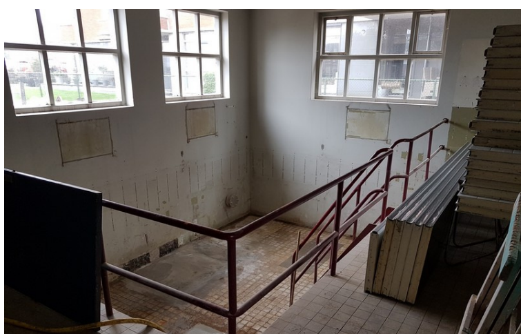
Foto 3: plaats voormalige dieselloletank / noordelijke hoek pompgebouw
