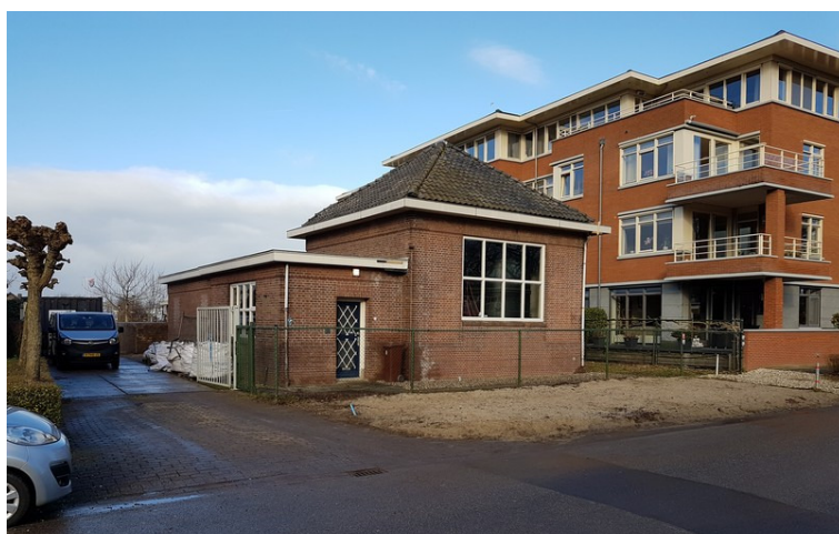
Foto 1: zuidzijde locatie / oprit en voormalig pompgebouw
