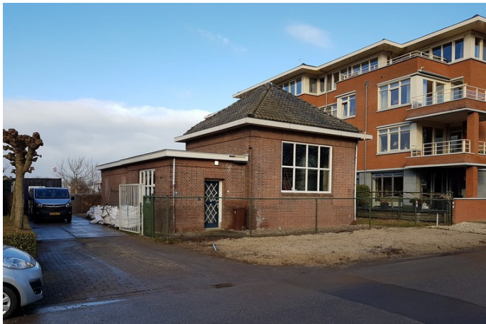
Foto 1: zuidzijde locatie en belendend perceel (Julianalaan 14 en voormalig Julianalaan 10-12)
