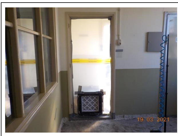
Foto 5: Aanzicht odm in foliewand.
