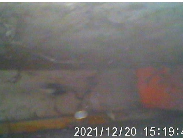
Figuur 11 Foto binnenzijde Trespaplaten, geen vleermuizen
