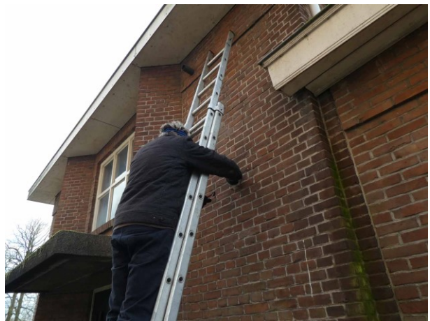
Figuur 13 Inspectie zijgevel
