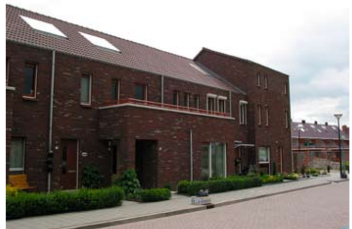
aanbouw, gerealiseerd in deelplan 2
