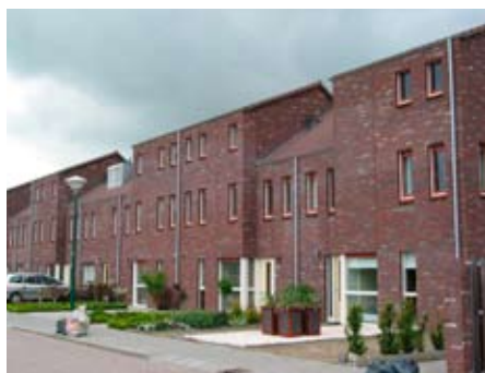
bestaande bebouwing waar deelplan 4 op aansluit
