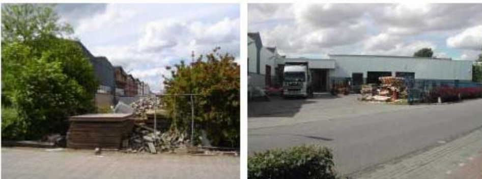
Opslag van afval en goederen in de buitenruimte: rommelige aanblik
