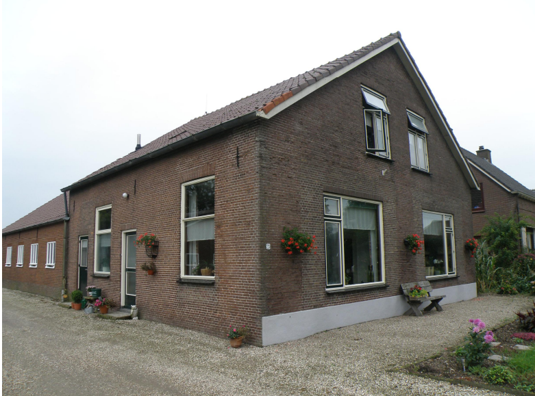
Afbeelding 1.2: pand 1 woning en deel
