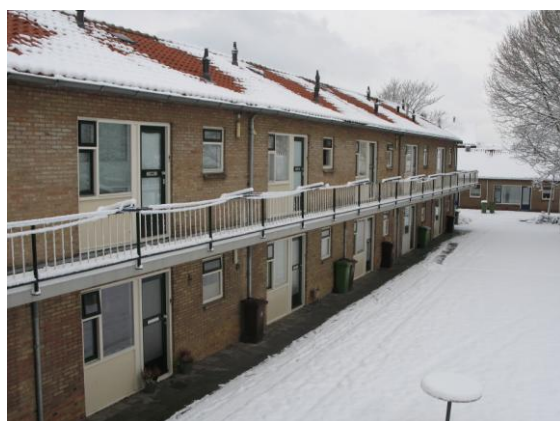
De te slopen woningen aan de Oranjestraat.
