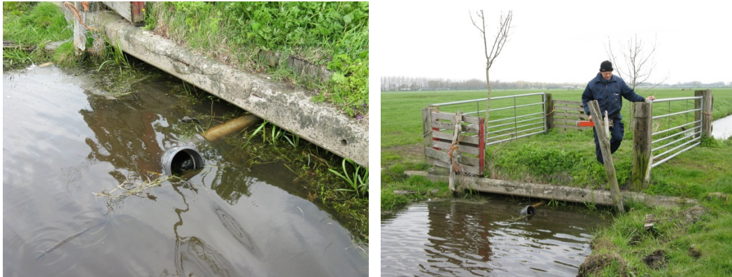
Figuur 9: Voorbeeldfoto's van duikervoorziening met draaimonding, mogelijk kan hier ook gezocht worden naar "watereducatie".
