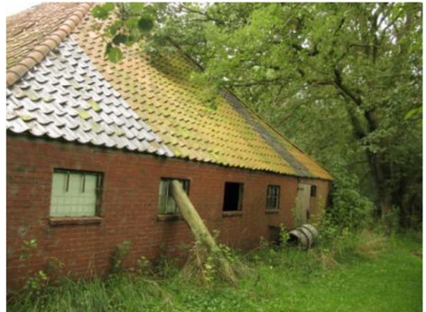
Foto 3: De achterzijde van de schuur is voorzien van steunbalken. Rechts is de monumentale zomereik te zien.
