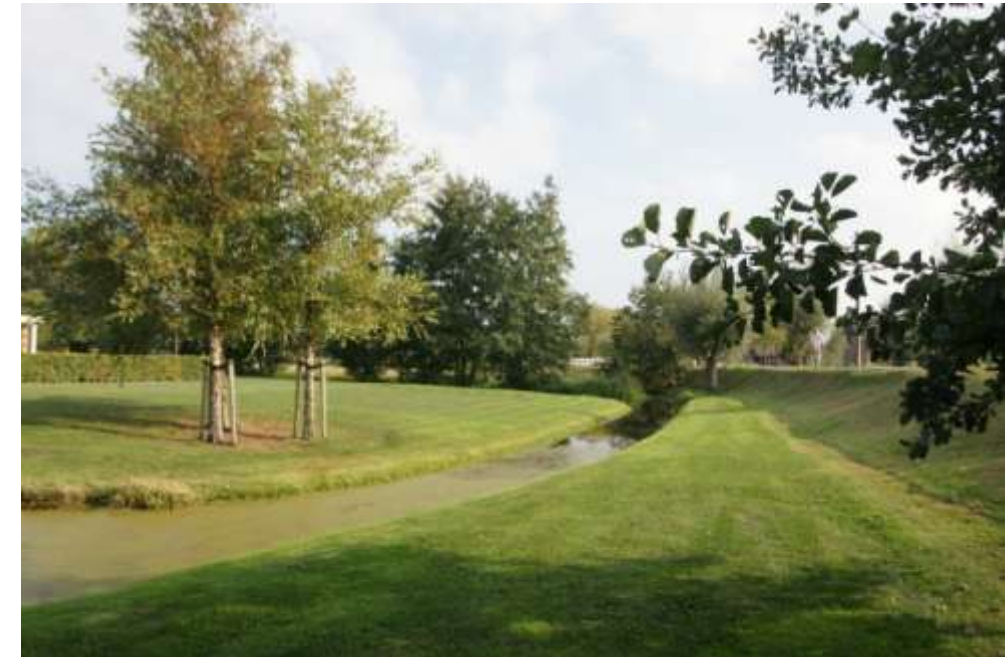
Voorbeeld 1 profilering en hellingshoeken vanuit taluds langs waterpartijen.
