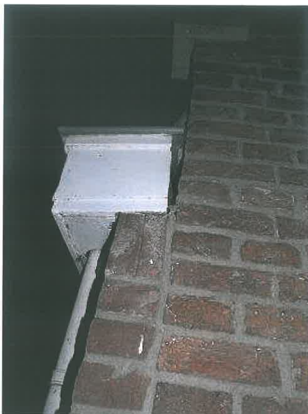
(Locatie paarverblijf op hoek Nieuwstraat/Gasplein)
