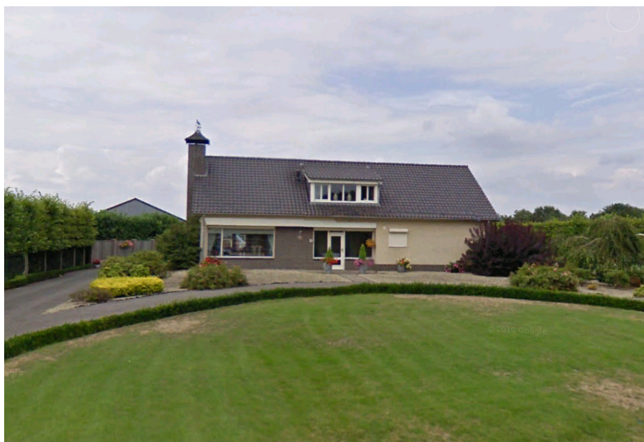
Foto 1; de bestaande woning
