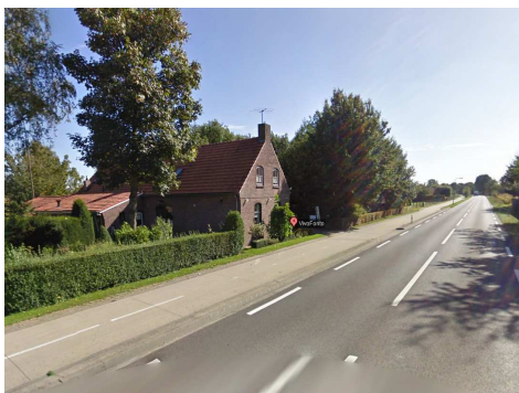
Bestaande situatie Roggelsedijk 9 (Bron: Google Streetview, 2010)
