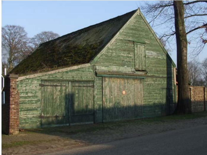
Figuur 17: De in de zuidwesthoek van de voormalige tuin gelegen grotendeels uit hout opgetrokken schuur. Deze dateert van na 1936 en heeft gefungeerd als timmerwerkplaats van broeder Franciscus.
