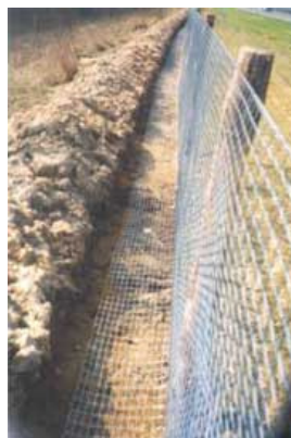
Figuur2: voorbeelden van het toe te passen kleinwild raster.
