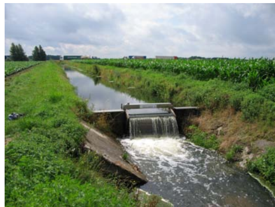
Figuur 7: Stuw in de Lage Heidelossing. Op de achtergrond de A67.
