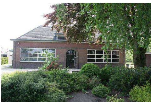
Schoolgebouw vanaf de straatzijde
