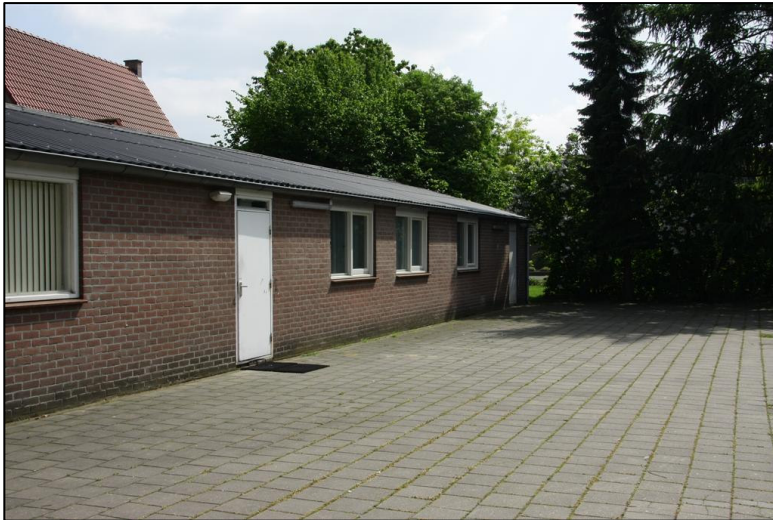
Figuur 5: Het te slopen bijgebouw.
