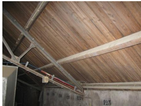
Foto 10. Dakbeschot onder de dakpannen van de mengvoerfabriek.
