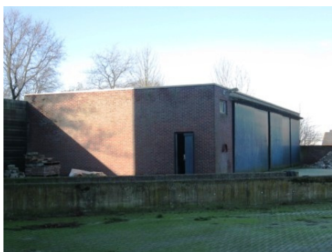
Foto 5. Oude opslagloods aan de achterzijde van de mengvoerfabriek.
