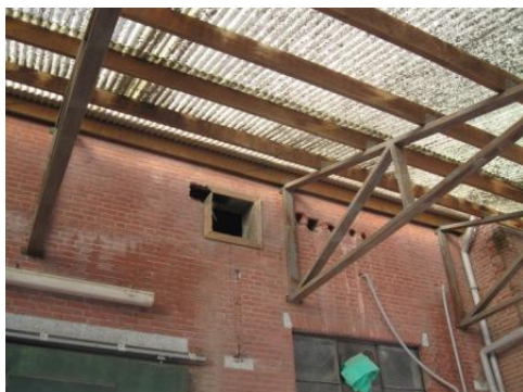
Foto 11. Enkele van de talrijke openingen die vleermuizen en vogels toegang kunnen geven tot de mengvoerfabriek.
