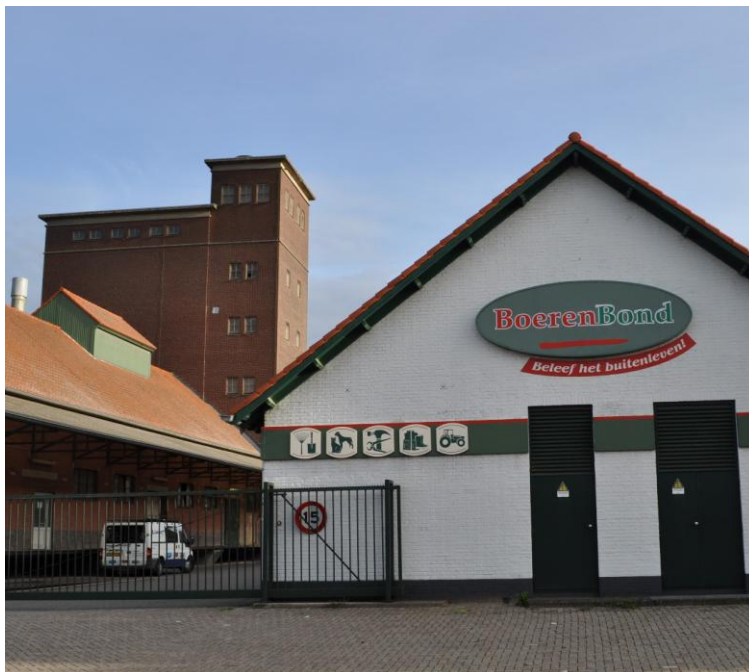
Foto 1: vooraanzicht perceel Steenstraat 74 te Panningen
