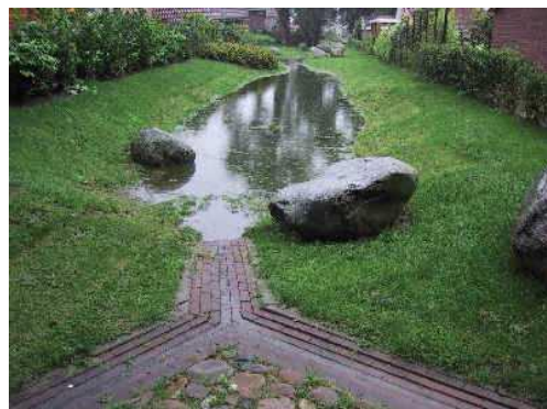
Afbeelding 4.1: Schematische weergave en voorbeeld van een direct infiltratiebassin of greppel
