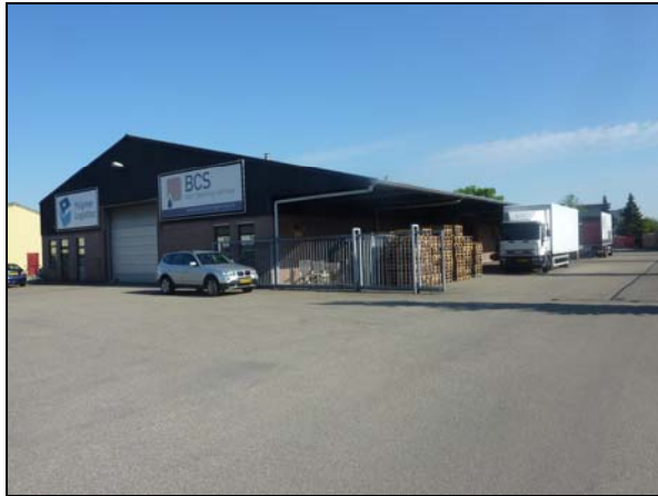
Afbeelding 6: Voorzijde bestaande loods
