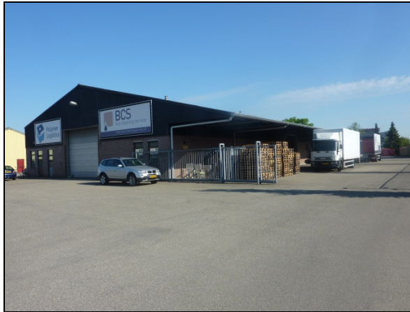
Afbeelding 6: Voorzijde bestaande loods
