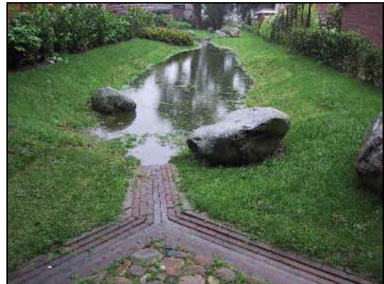
Afbeelding 4.3 en 4.4: Schematische weergave en voorbeeld van een direct infiltratiebassin of greppel
