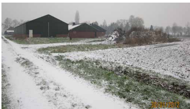
Foto 3: Achterzijde stallen met grondwal
