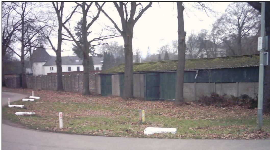
Afbeelding 11. Aanzicht van het kasteel vanaf de hoek de Berckt – Legioenweg (op de voorgrond de kippenschuur die plaats dient te maken voor of verbouwd wordt tot een horeca-/recreatieruimte)
