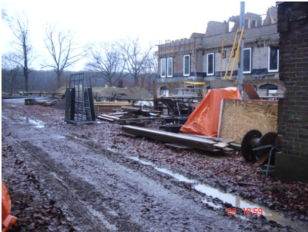
Foto 1: Verbouwing tot groepsaccomodatie
