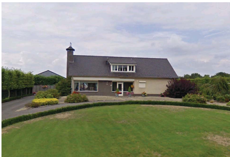
Foto 1; de bestaande woning
