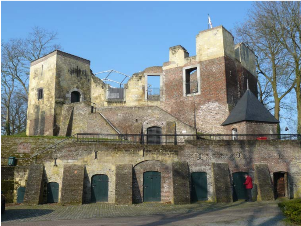
foto 5. Gewelfjes aan onderzijde van Kasteel Kessel. Geschikt te maken vestigingsplaatsen voor vleermuizen.
