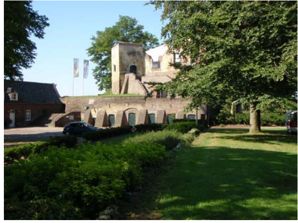
Foto 8: In het midden van de onderzoekslocatie staat een muur die de onderzoekslocatie splits in een hoger en een lager gedeelte.
