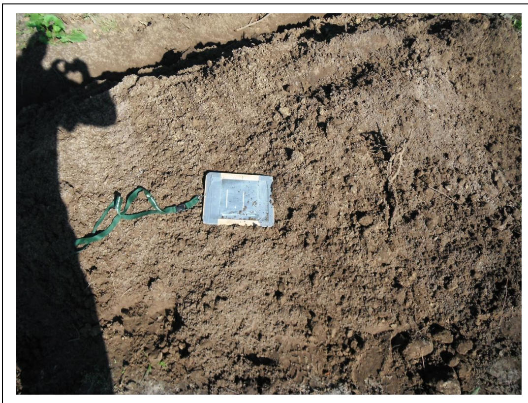
Foto 1. Opgegraven, gezeefd materiaal asbestinspectiesleuf 1.1
