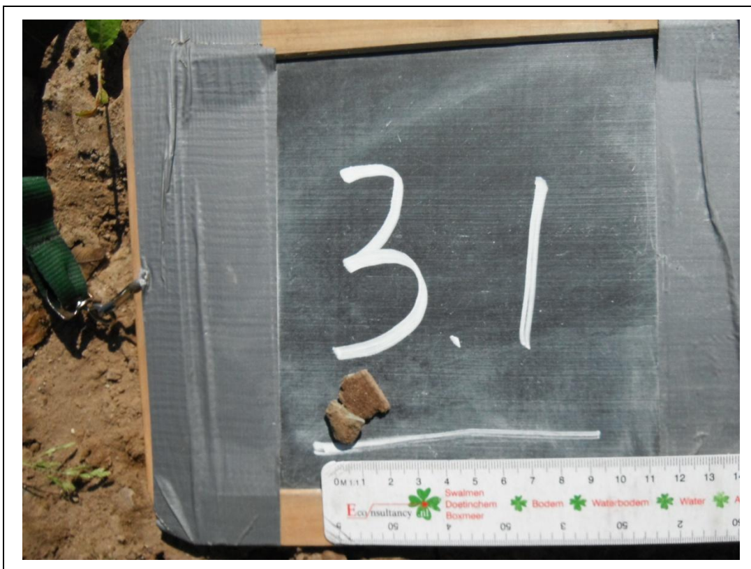
Foto 16. Asbestverdacht plaatmateriaal asbestinspectiesleuf 3.1
