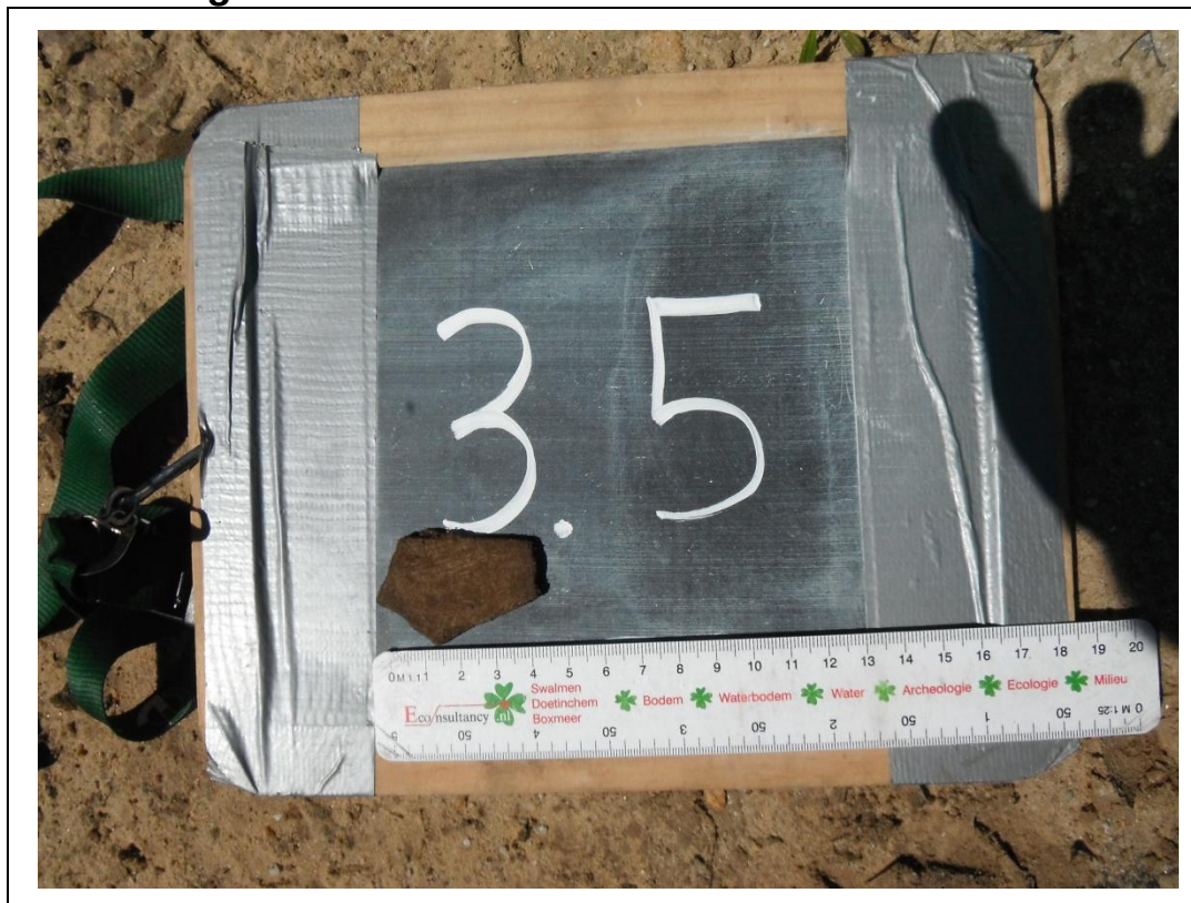
Foto 21. Asbestverdacht plaatmateriaal asbestinspectiesleuf 3.5
