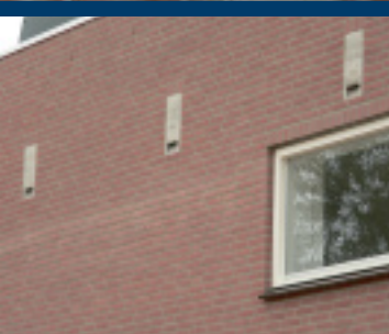
Boven: inbouwen van een verblijfplaats voor vleermuizen
