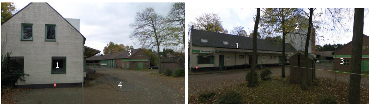
Afbeelding 2. Situatie voor de sloop. 1 = boerenbondgebouw, 2 = silo, 3 = bijgebouwen en 4 = weegbrug.
