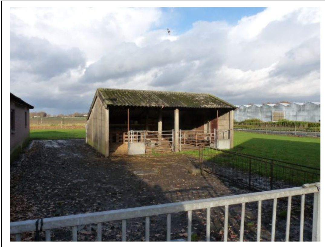
Foto 3. Te slopen open kapschuur, oostelijk deel onderzoekslocatie.
