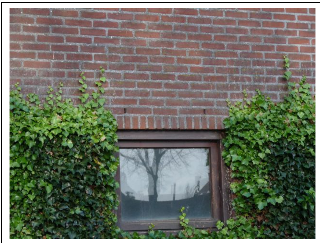
Foto 4. Spouwgangen en klimop aan de varkensschuur.
