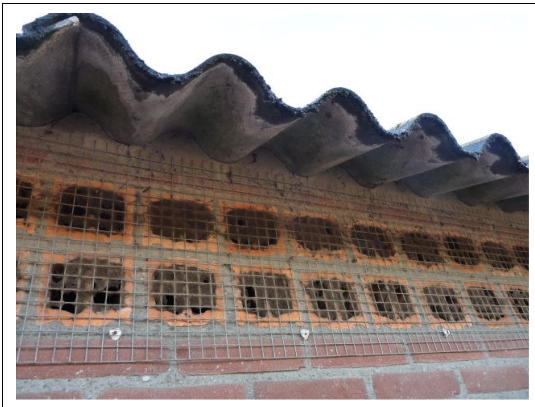
Foto 5. Openingen in de slopen schuur zijn grotendeels afgedicht.
