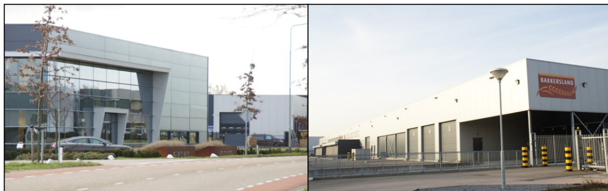
Figuur 12: Impressie industrieterrein Panningen
