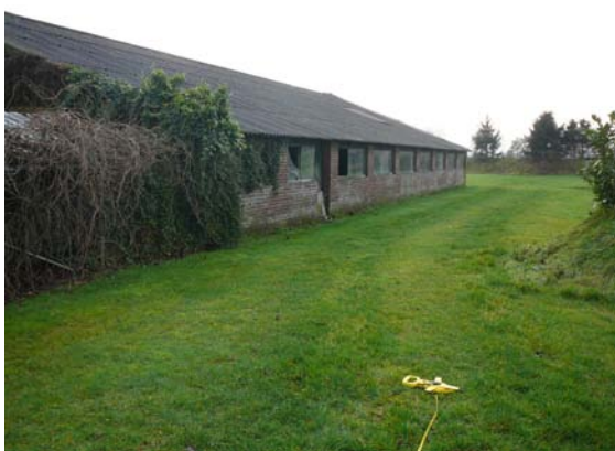
Schoor zuidoostelijke zijde (asbestgolfplatendak en betonvloer)
