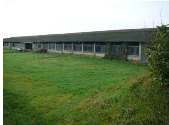
Schoor zuidwestelijke zijde (asbestgolfplatendak en betonvloer)
