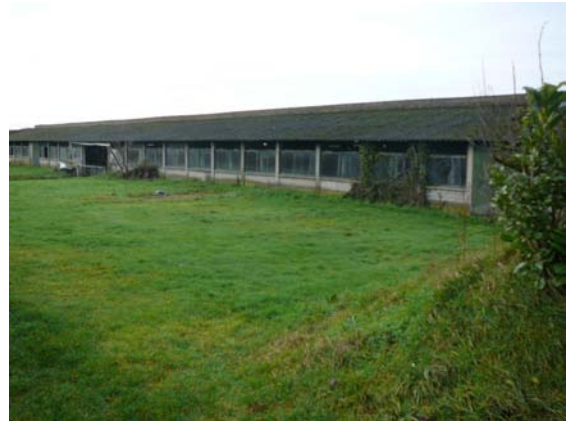
Schoor zuidwestelijke zijde (asbestgolfplatendak en betonvloer)
