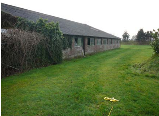
Schoor zuidoostelijke zijde (asbestgolfplatendak en betonvloer)
