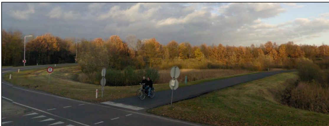
Figuur 2.7: een regenwaterbuffer / wateropvangbekken in de toerit naar de N277
