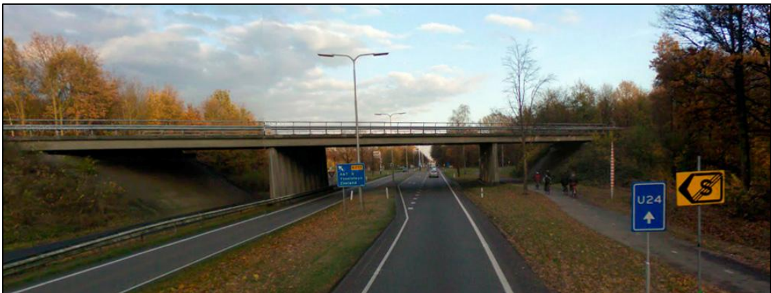
Figuur 2.2: De N275 gezien in oostelijke richting, ter plaatse van het kruisingsvlak met de N277 (kunstwerk)
