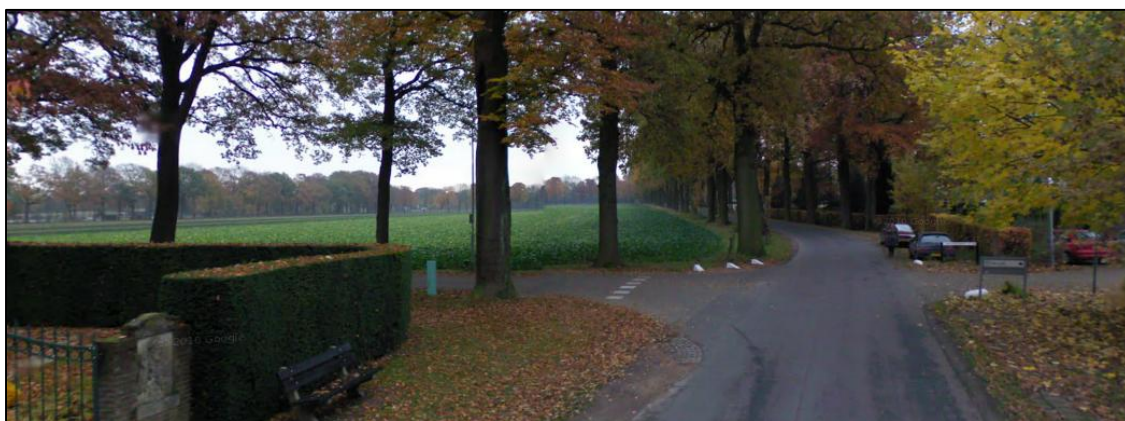
Figuur 2.3: De Koningstraat gezien in zuidelijke richting, met rechts de aansluiting Koningserf (locatie Daelzicht)
