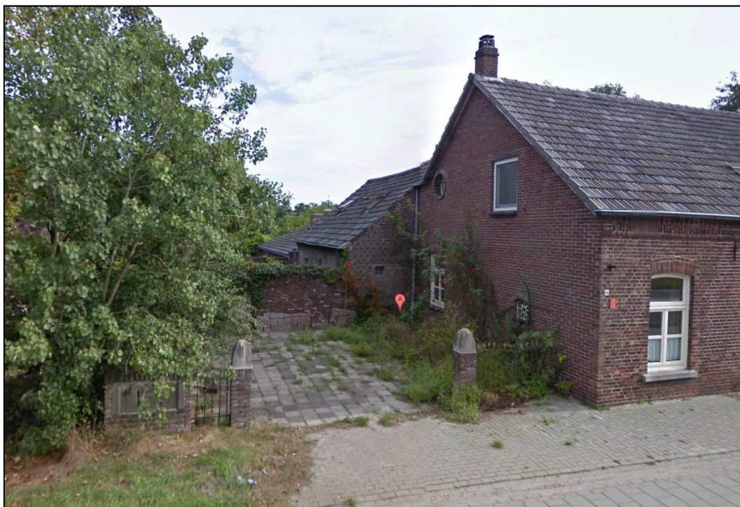
Afbeelding 9. Voorhuis, achterhuis en voormalige stal, gezien vanaf de Meijelseweg (bron: Streetview Google Maps)
