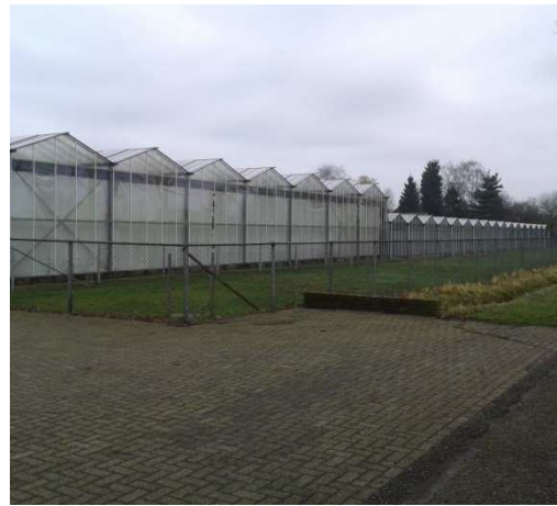
Te behouden kassen links, te verwijderen complex rechts.
